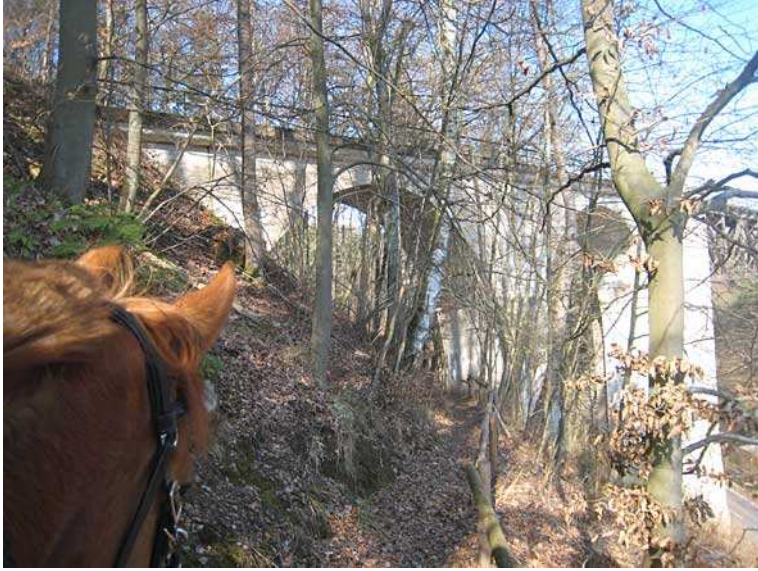
Alte Eisenbahnbrücke am Eiswoog
